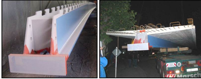
Şekil 7 Çelik-beton kompozit prefabrik köprü elemanı.
